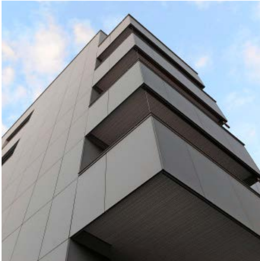
Mehrfamilienhaus in Zürich, von Viriden+Partner renoviert: Die aktive Glasfassade ist mit eingefärbten monokristallinen Modulen ausgestattet.
