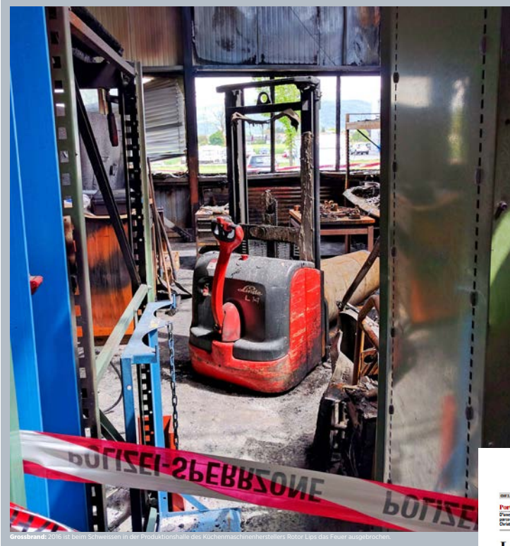
Grossbrand: 2016 ist beim Schweissen in der Produktionshalle des Kuchenmaschinenherstellers Rotor Lips das Feuer ausgebrochen.
